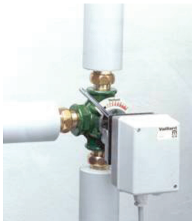
Fig. 7.10. Valvule përzierëse e kontrolluar automatikisht (me servomotor)
