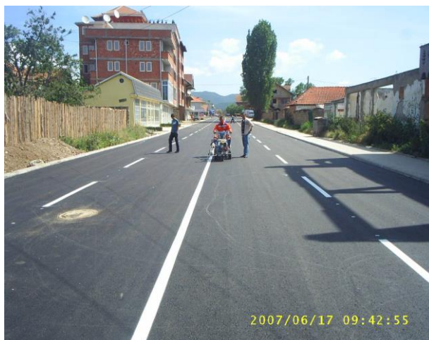
Figura 27 - Makina për sinjalizimin horizontal dhe mënyra e punimit në rrugë
