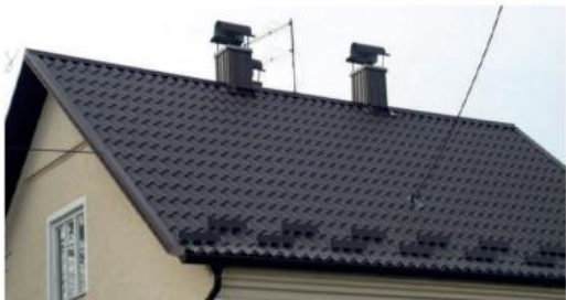
Fig. 144 Mbulesë çatie prej llmarine
