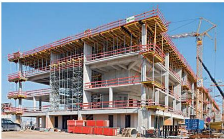
Fig. 84 Objekti në sistemin skeletor të konstruksionit
