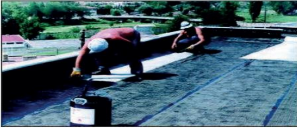
Fig. 69 Hidroizolimi i çatisë së rrafshët
