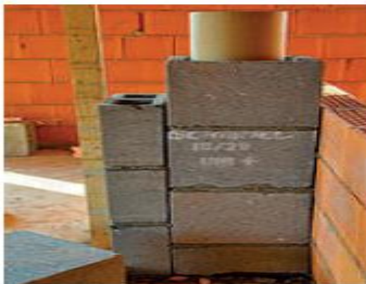
Fig. 117 Kanal ventilimi prej elementeve të parafabrika
