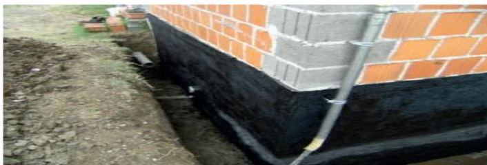
Fig. 101 Hidroizolimi vertikal i murit me shiritin bitumeni
