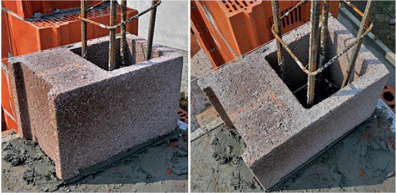
Fig. 115 Realizimi i shtyllës me beton-arme me blloqe të rifabrikuara në vend të kallëpit klasik
